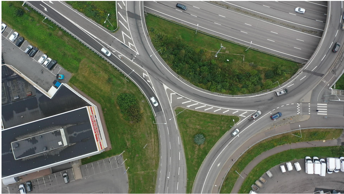
Figur 19 Befintlig utformning av Munkebäcksmotets södra halva. Foto från drönarfilmningen.
