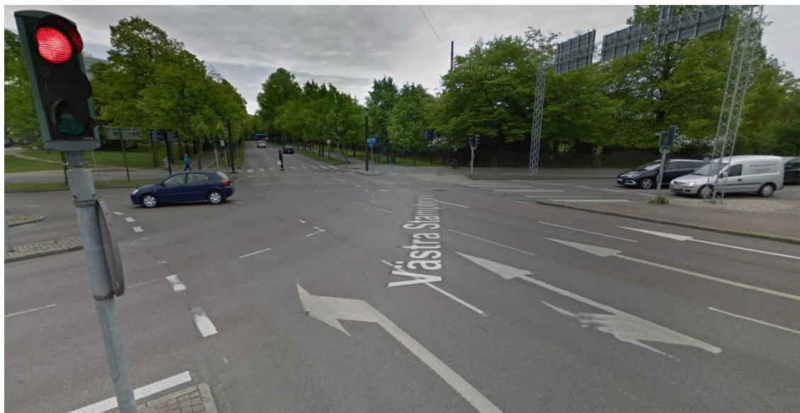
Figur 50 Exempel från korsningen Nya Allén/Ullevigatan där man har en liknande lösning med dubbla vänster, där det högra av dessa två även tillåts för rakt fram. Även här går all trafik på huvudsignalen, dvs. det finns ingen vänsterpil.
